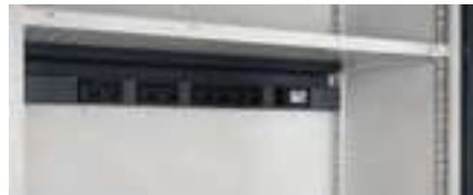
Anbringung des Energiekanals im unteren Bereich des Lochbodens/der Lochplatte
