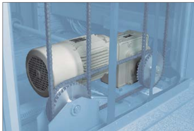
Az erős és nagy hatásfokú motorok révén, a liftegység eléri a 2.3 m/sec függőleges sebességet
